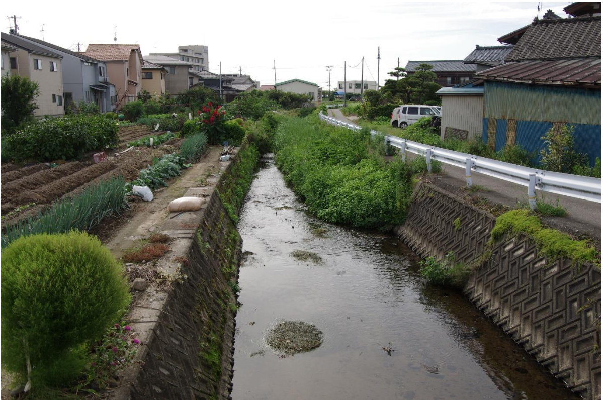
土砂が堆積し川幅を狭めている大沢川の状況（下鍛冶屋地内）
