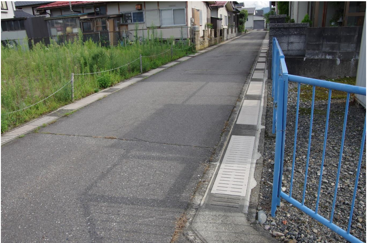
ECONBI工法により改修された側溝（坂町住宅地区）
