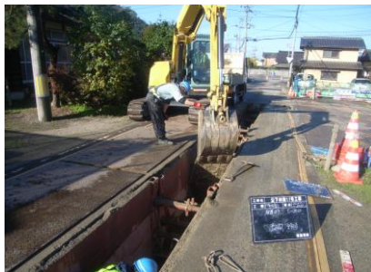
汚水管渠整備事業
