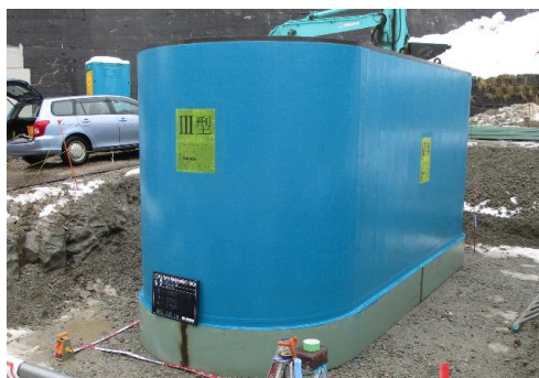
埋設型防火水槽の設置 (H29年度貝附地内)
