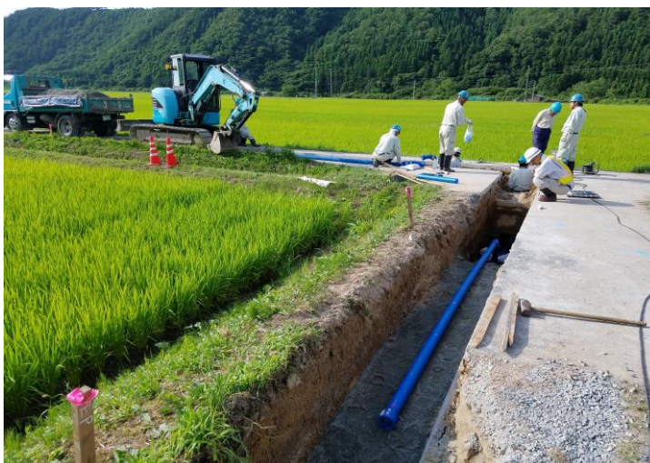
老朽管路更新工事
