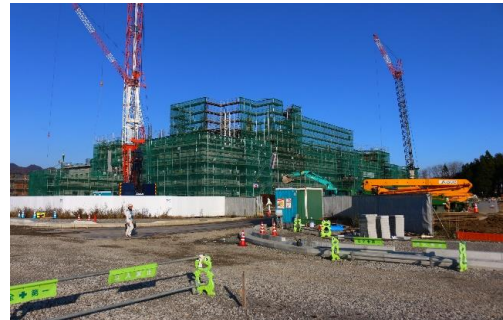
工事中の新村上総合病院
