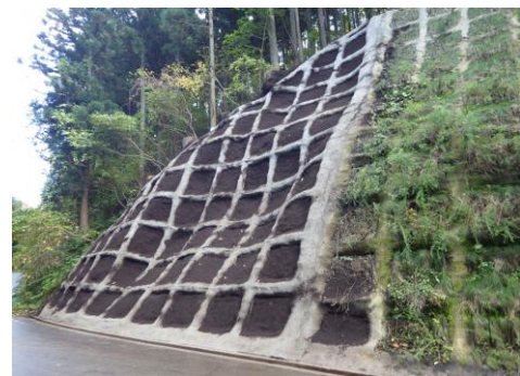
復旧済みの林道
