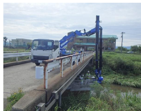
橋りょうの点検状況
