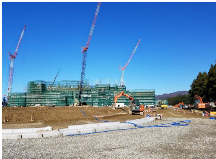
重要供給拠点施設（建設中の厚生連村上総合病院）
