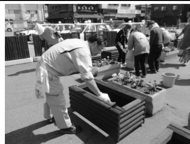
村上駅前ロータリーのプランター木枠整備
