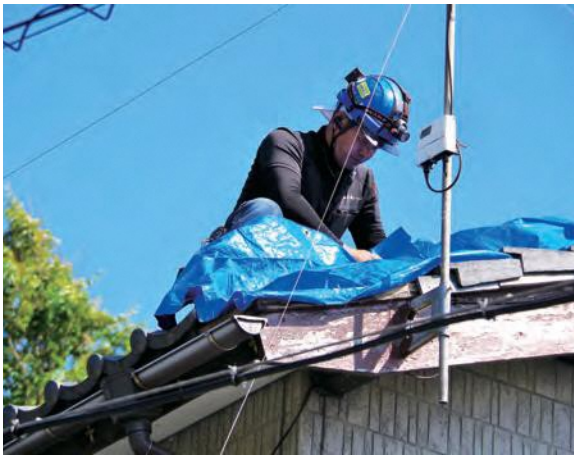
被災した民家の瓦屋根を応急措置するボランティア
