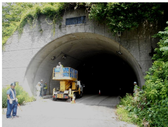
平成 30 年度 トンネル定期点検 市道三面小国線 宇連萩トンネル
