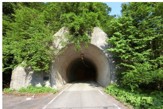
市道三面小国線 舟曳トンネル
