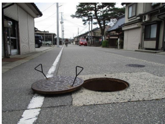
写真 消雪パイプ用井戸を二次利用した消防水利
