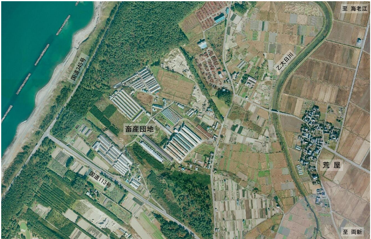
胎内市乙地内の畜産団地（航空写真）
