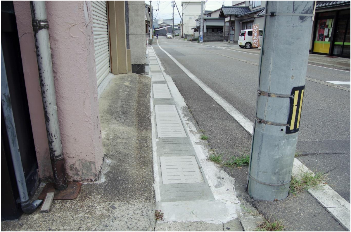
ECOンビ工法により改修された側溝（坂町駅前地区）
