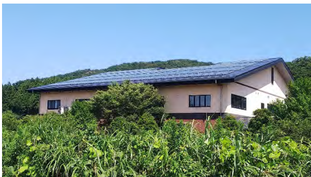
し尿処理施設での屋根貸し
