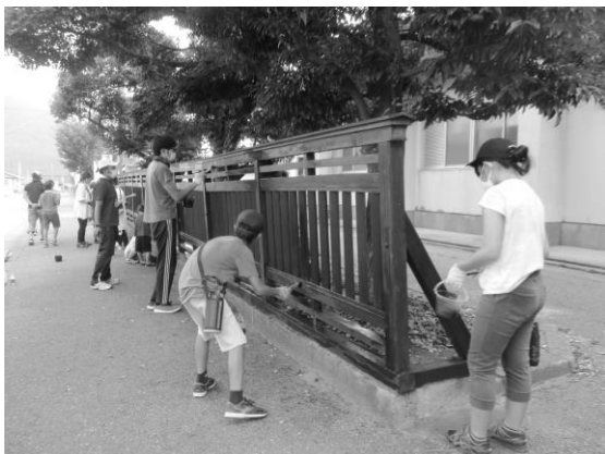
村上小学校木製フェンスペンキ塗り活動
