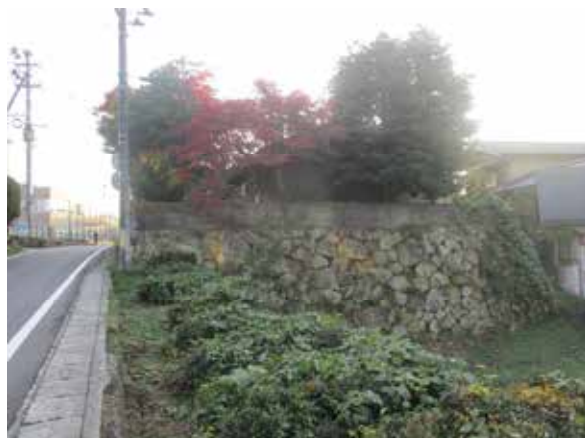
下渡門跡の石垣上に建つ家屋（史跡未指定地） 現在は無人となっている。
