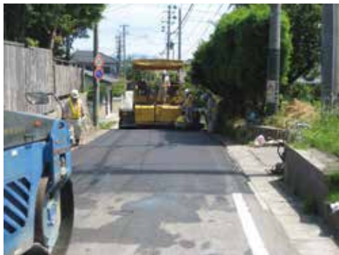
下渡門跡路面再舗装
