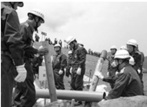
水防対策の一つ、「月の輪」作製の様子
