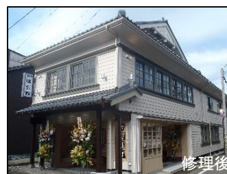
倉庫をリノベーションして開業した「うおや塩引き館」
