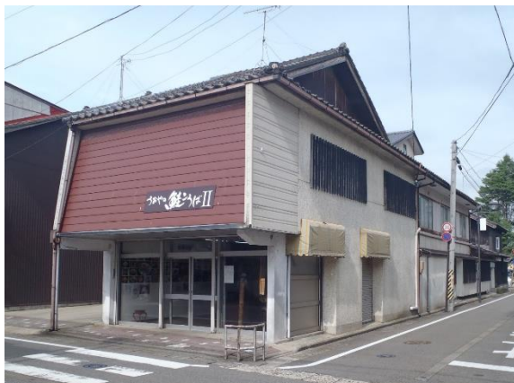
修理・修景前
