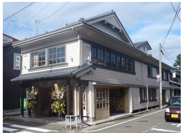
修理・修景後
