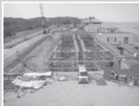
増設が進む 村上浄化センター (瀬波温泉地内)
