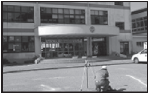
海拔測定作業の様子(上海府小学校)
