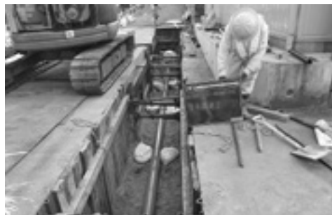
下水道工事の様子
