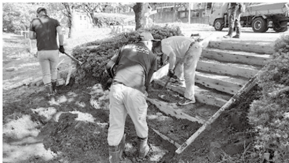
▲階段の枠内に土を入れて固定
