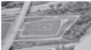
完成したヘリポート
