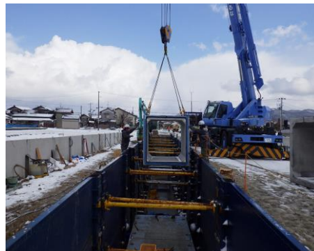
烏川1-3号雨水幹線函渠工事
