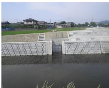
烏川1-3号雨水幹線樋門
