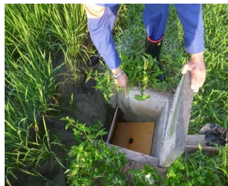
田んぼダムの取組（排水調整板の設置）
