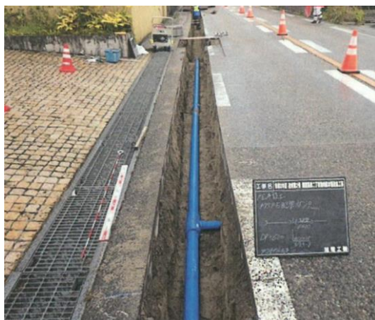
水道管路更新工事
