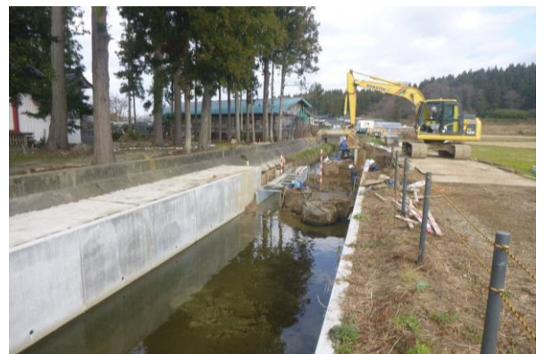
普通河川滝矢川の改修
