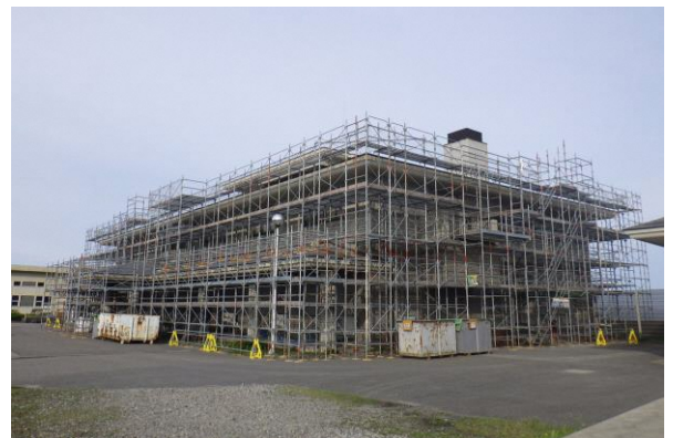
村上浄化センター改築更新工事
