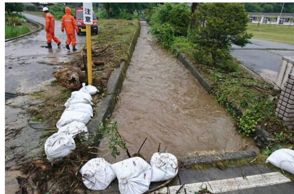
大雨による水路増水
