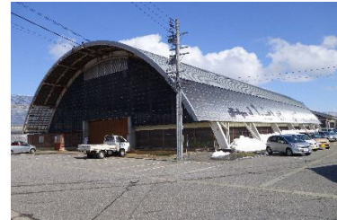
屋根付き多目的広場（現況）
