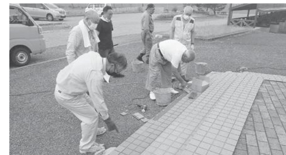
▲神林中学校玄関前のタイルの補修作業
