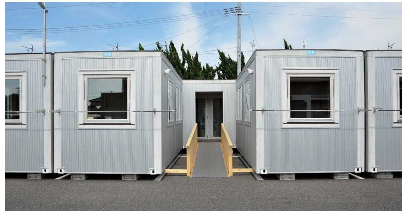
▲荒川地区公民館裏に33世帯入居可能な応急仮設住宅が完成しました
