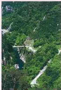
朝日スーパーライン (奥三面発電所付近)
