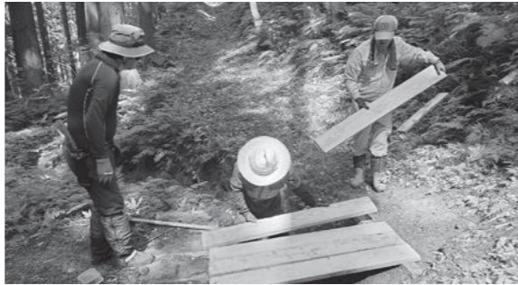
▲木橋の整備作業の様子
