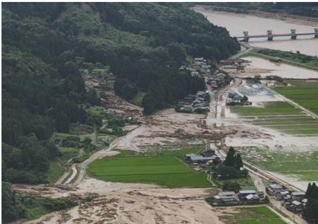
▲沢からの土石流（川部～小岩内）
