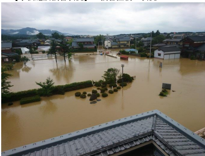
▲浸水した保内小学校正面玄関
