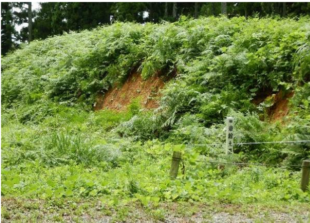
▲平林城跡の土塁の崩落
