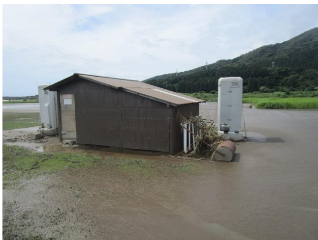
▲土砂流入（三面川東河川公園）
