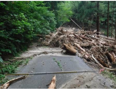
▲貝附地内 山腹崩壊による土砂流失・流木
