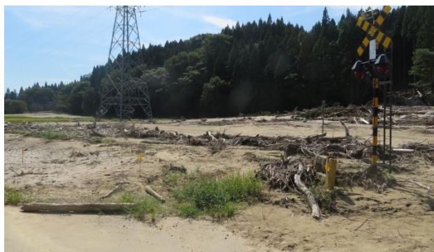
▲JR 米坂線の被害状況（荒川地域）
