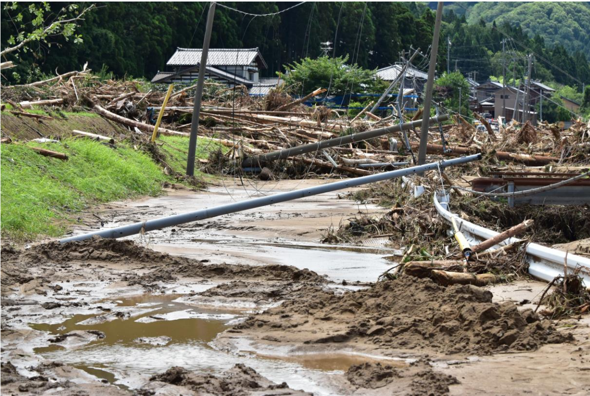
▲市道に堆積した、大量の土砂や流木(神林地域 小岩内)
