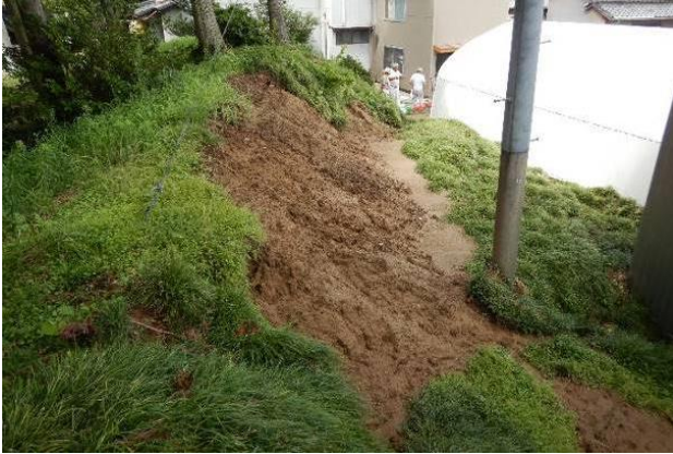
▲馬場館跡の土塁の崩落
