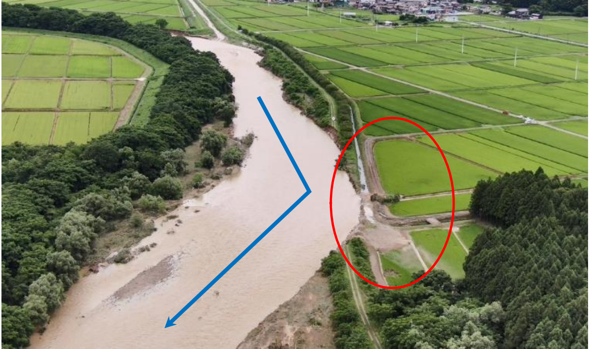
▲二級河川三面川水系高根川 堤防破堤箇所（朝日地域 黒田）
