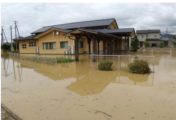
▲保内学童保育所 浸水被害の状況（床上浸水）
