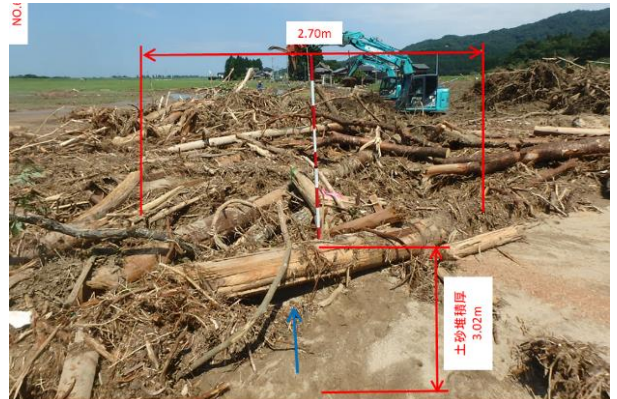
▲小岩内地内 岩鼻幹線用水路 土砂埋塞
