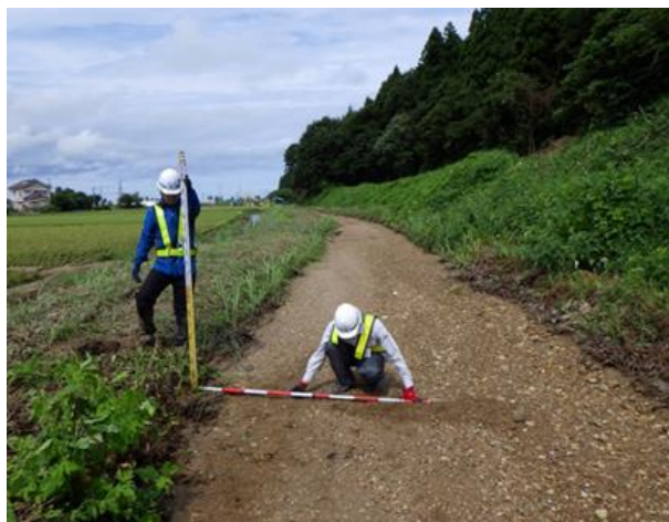
▲普通河川 赤坂川 堆積土砂撤去前
