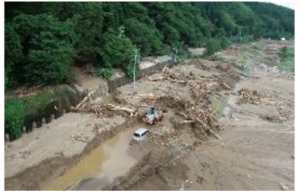
▲国道 113 号（土石流）
