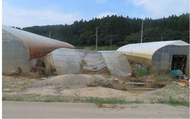
▲小岩内地内 土石流によるパイプハウス被害
