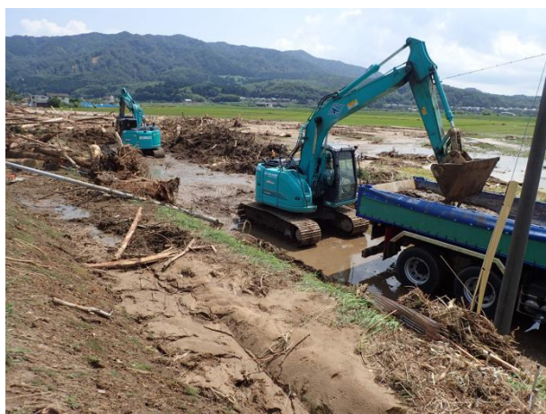
▲啓開作業状況
