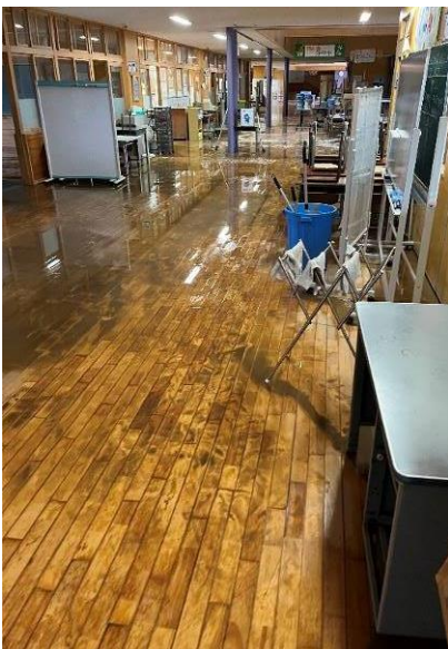
▲1階廊下（保内小学校）
