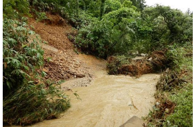
▲平林城跡の切岸の崩落
