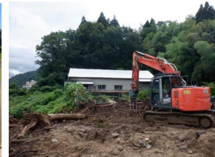
▲荒川漁協 稚魚水槽に土石流入
