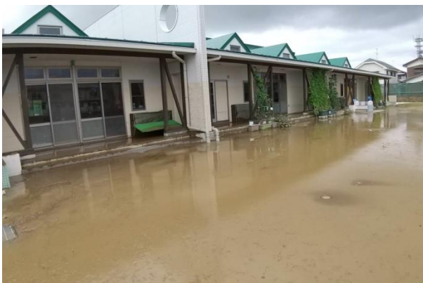
▲あらかわ保育園 浸水被害の状況（床上浸水）
