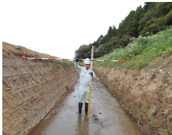
▲普通河川 赤坂川 土砂撤去後
