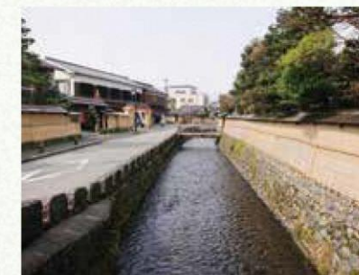
往時の土塀・石積護岸に改修した大野庄用水
