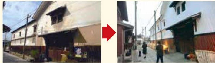
修理前 修理後
