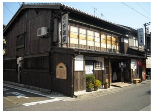
図 千年鮭井筒屋（井筒屋（鳥山家住宅））
