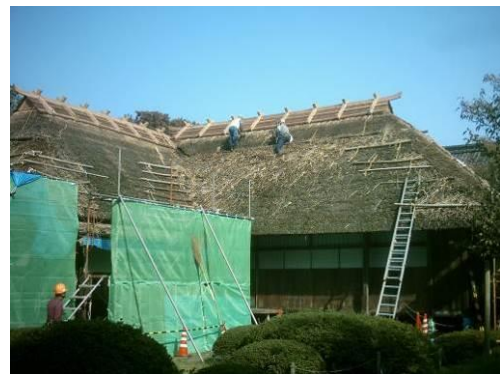
図 若林家住宅の茅葺き屋根の修復
