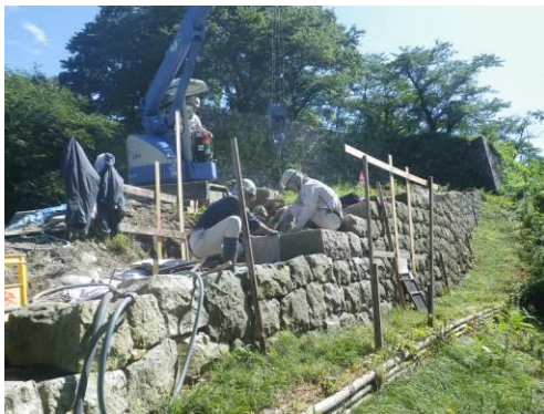
図 村上天跡の石垣の修復
