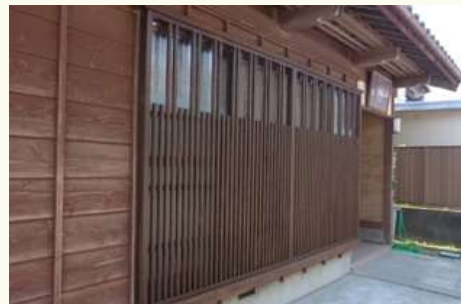
完成した出格子窓
