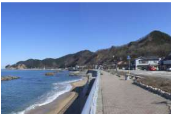
海岸の軸（国道 345 号：日本海夕日ライン）
