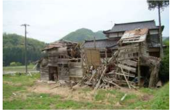
荒廃した建物
